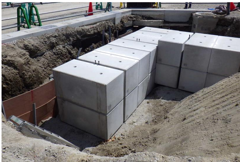
地中に埋められている基礎コンクリートブロック(約 2.4t/個) 写真提供：株式会社内藤ハウス
